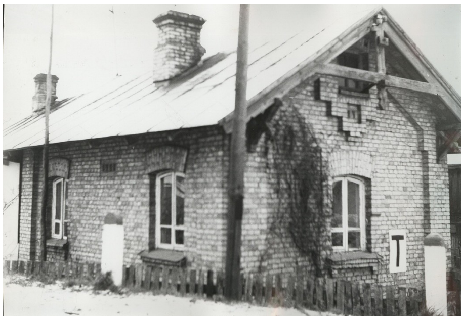
Budynek dróżnika z 1906 r.
