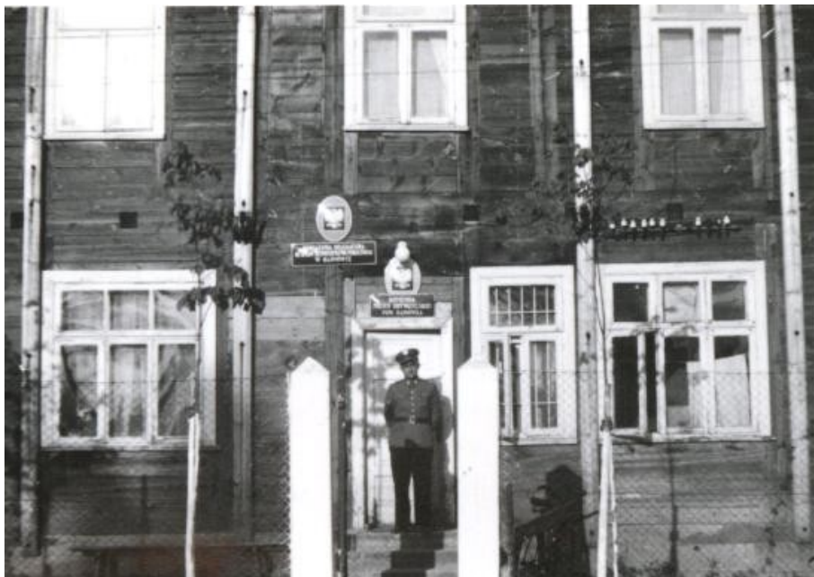
Budynek Komendy Powiatowej MO na rogu ul. Warszawskiej i Wojska Polskiego
