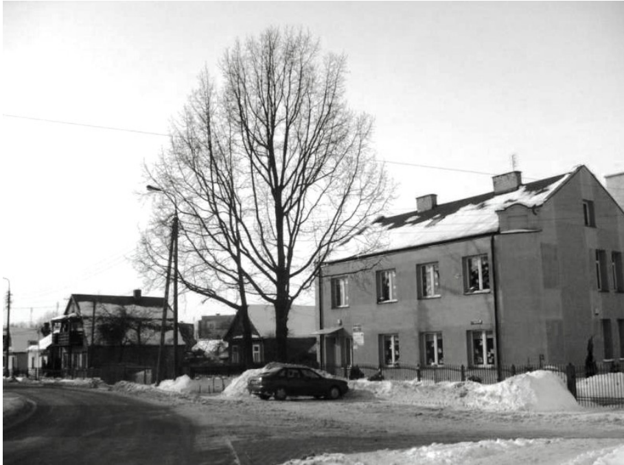
Początek ul. Warszawskiej, od prawej budynki Włodarskiego, późniejszego budynku Komendy Powiatowej Milicji Obywatelskiej
